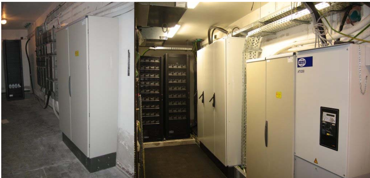
13. ábra. Az alagsori áramelosztó átalakítása
