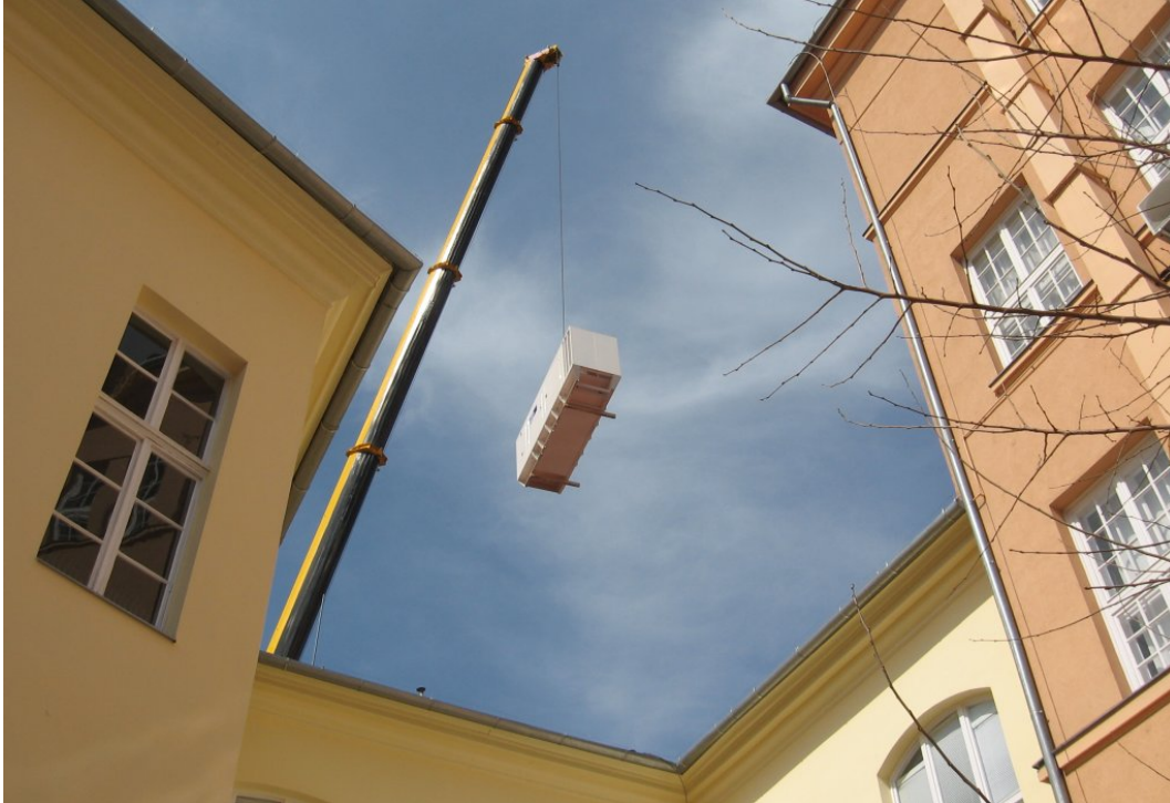
16. ábra. A 220kVA-es gép beemelése az udvarra
