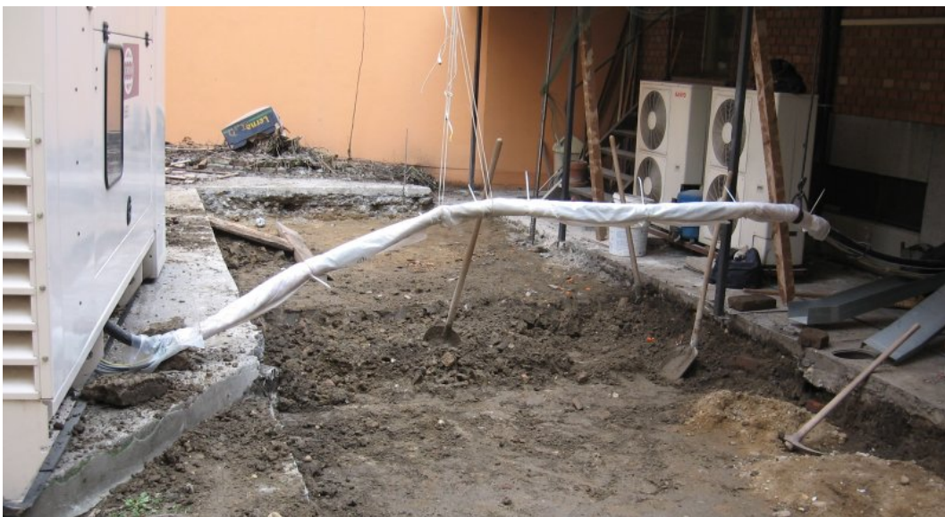
15. ábra. Készülőben az új gépalap
