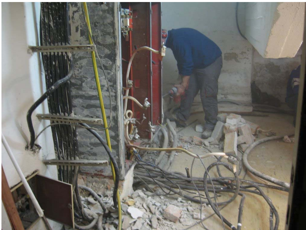
9. ábra. A régi főelosztó bontása
