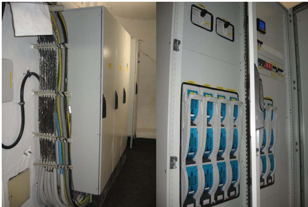
10. ábra. Az elkészült főelosztó zárt és nyitott ajtókkal
