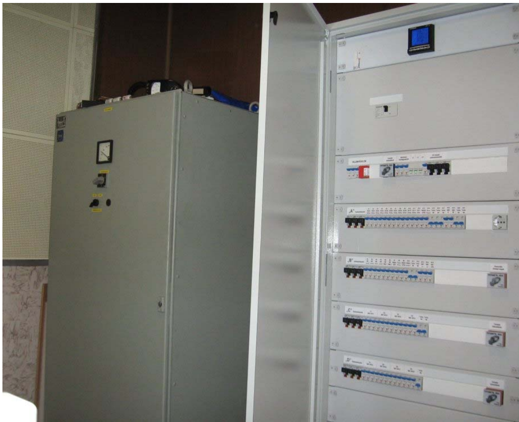
12. ábra. Az új géptermi elosztó és elődje
