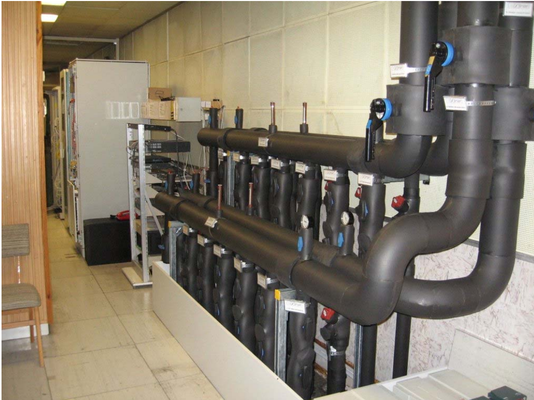
20. ábra. Az elkészült osztó-gyűjtő
