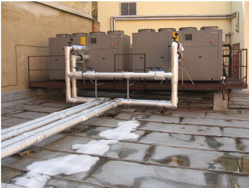
21. ábra. A kültéri vízűtő berendezések
